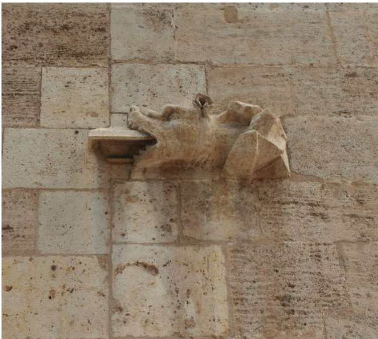
1.1 Valencia, loggia a ridosso del Consolato del Mar, prospetto principale, particolare. (foto dell'autore)
